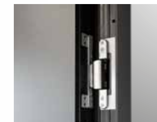
Dolda gångjärn – osynliga när dörren är stängd.
